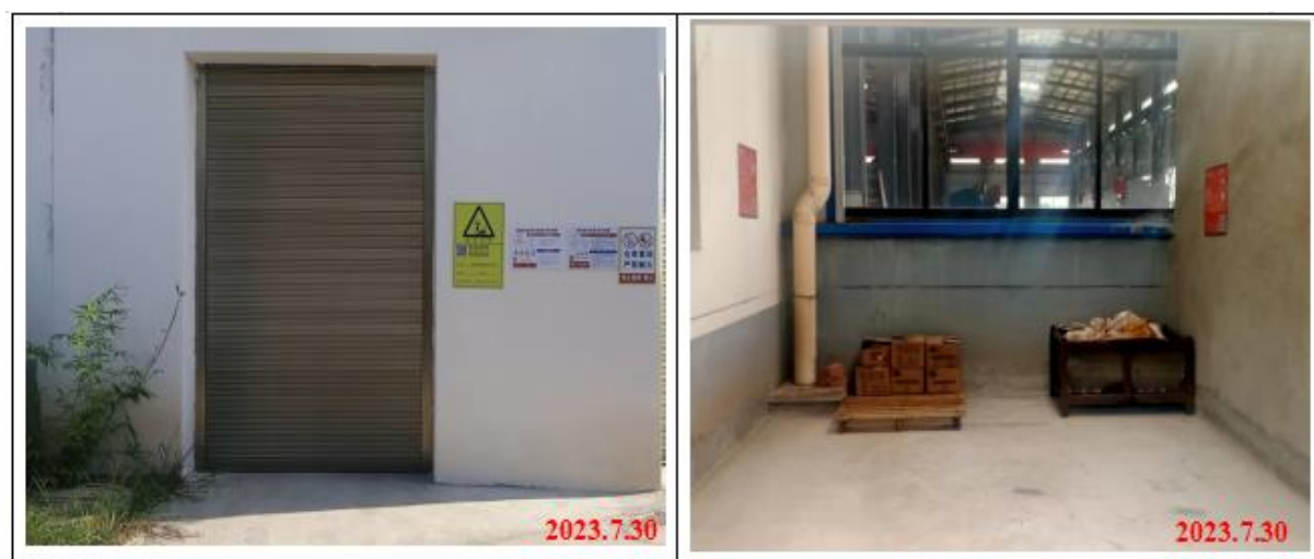
图 7.4-1 本次技改依托的危废暂存间设置的标识牌
